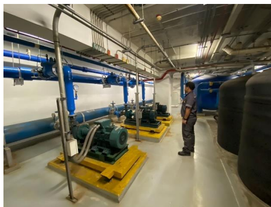
รูปที่ 42 ทดสอบการทำงานของเครื่องสูบน้ำ
